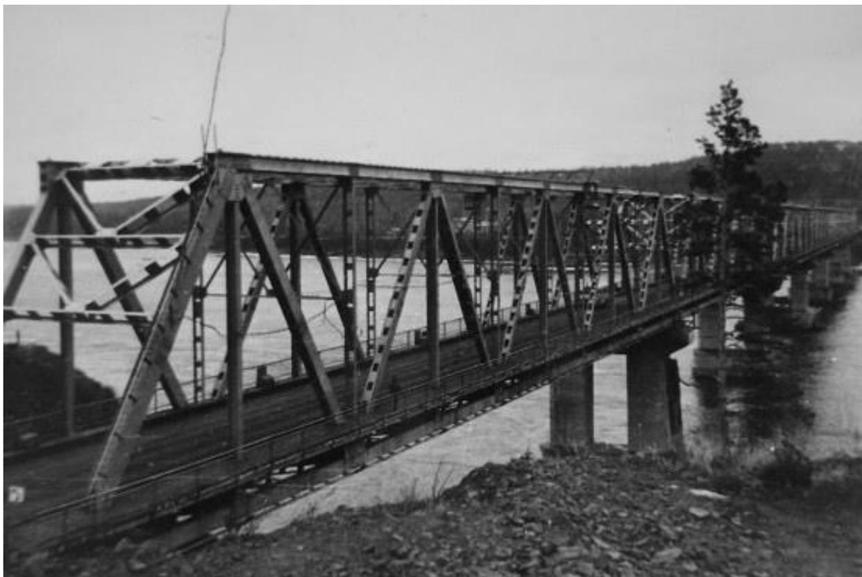
Движение по новому мосту было открыто в октябре **1981** года после испытания. На каждый из семи пролетов была дана нагрузка в 500 тонн веса, которую мост успешно выдержал. Его грузоподъемность увеличилась почти в два раза.
